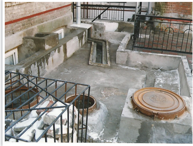
ניתן לראות כיסוי של הבורות, ותעלת המשכה מי גשמים כשמכוסה (תמונה העליונה) וכשאינה מכוסה (תמונה התחתונה)
